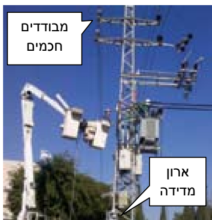
איור 4 – התקנה תחת מתח
